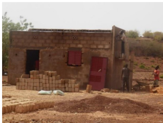
建設中の搾油作業用の建物。雨季の始まる前に完成する予定です。（フルー村）
