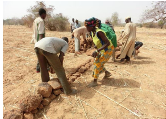
男性も女性も、住民総出の共同作業によって、石は並べられていきます。
