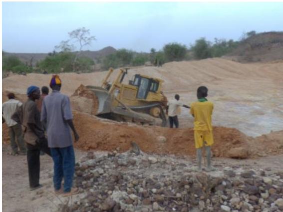
ブルドーザーによるブリ掘り下げ作業の様子。 住民も作業を見守っています。
