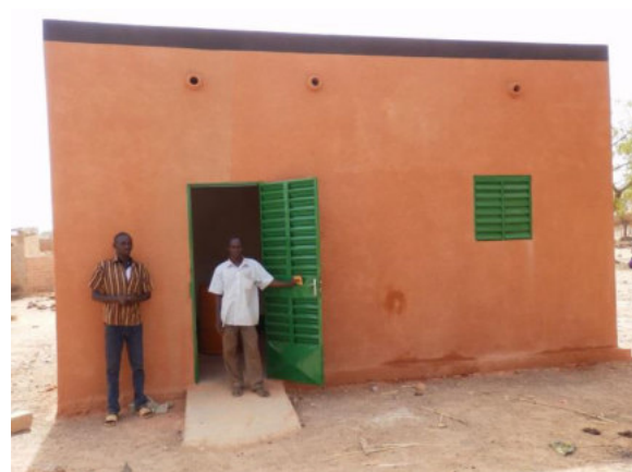
男性が立っていますが、タンポンガ村に建てられた女性組合が搾油作業を行なう建物です。
