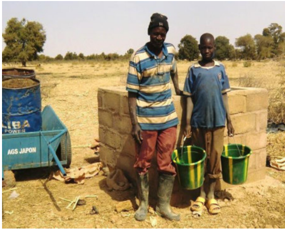
コンディビト村に建設された貯水槽。運んできた湖水を溜め、水やりに使います。
