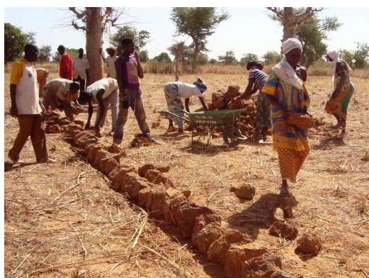
共同作業で進められるディゲット設置。
