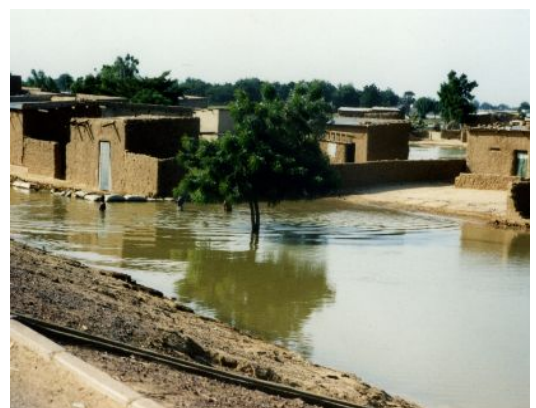
1998年にワリア地区で発生した洪水。居住区全体が水に覆われました。
