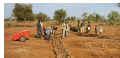
タンポンガ村での石堤設置の様子
