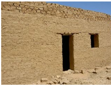
建設中の裁縫グループアトリエ
